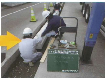
6 ブロック吊り込み設置
