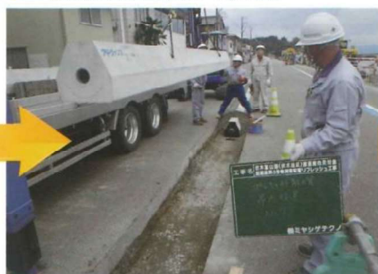
5 接続短管挿入状況
