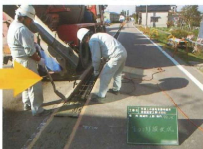
5 コンクリート打設
