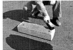
No.3 ブロック及び舗装の接着面を掃除し、ブロック接着面に水打ちをします。(※ドライアウト防止の為)
