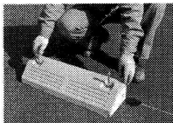
No.6 ホルダーにアンカーピンを挿入します。(舗装が硬い場合や骨材が粗粒の場合はφ10以下の下穴をあけて下さい。)
