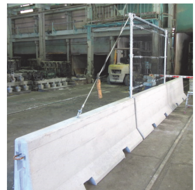
基礎擁壁に防護柵をセットした状況
